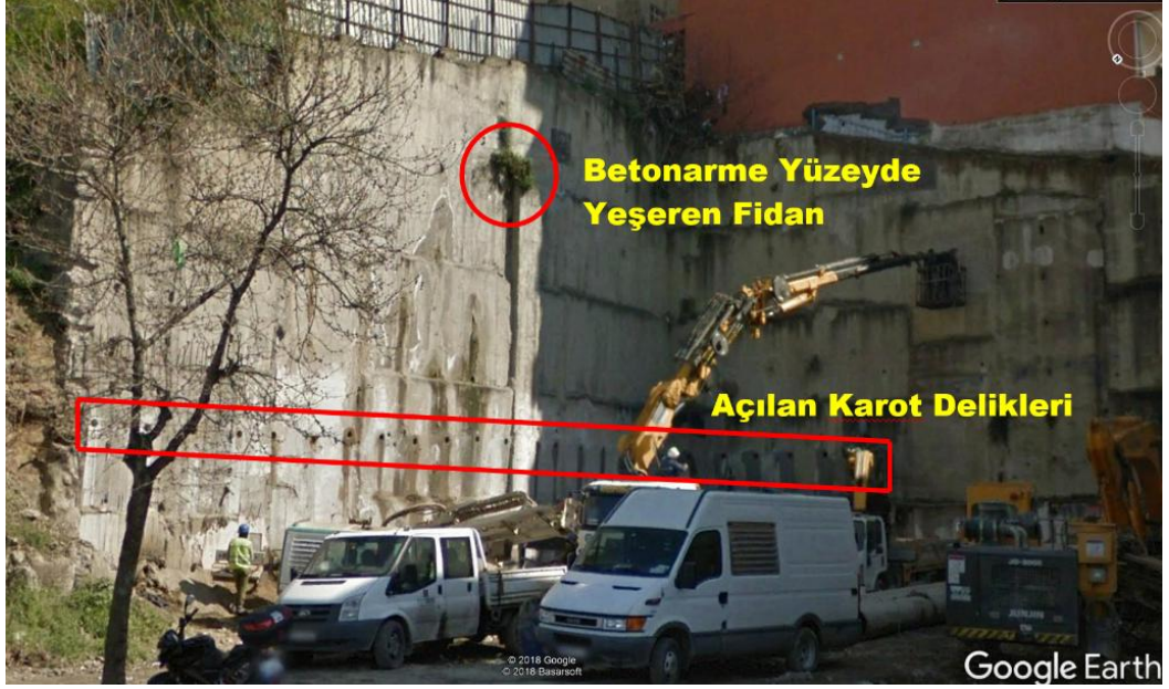
Resim-3 2753 ada 28 parselin mevcut betonarme dayanma yapısına sol ve arka cephede açılan karot deliklerinden ilave destek çalışmalarına başlandığını gösteren resim Kaynak: Google Earth verileri
